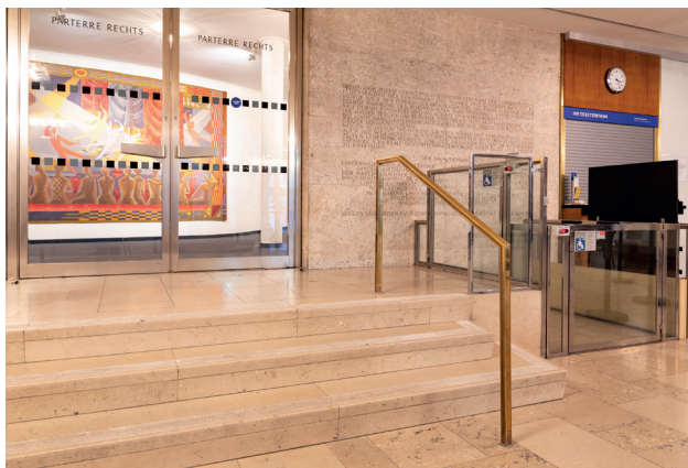
Hebebühne und Stufen zum Parterre
