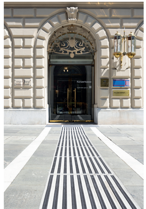
taktils Leitsystem Eingang Sparkassenplatz
