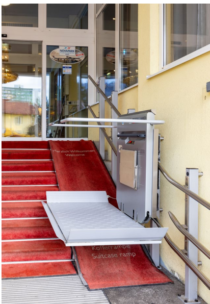
Eingang mit Treppenlift
