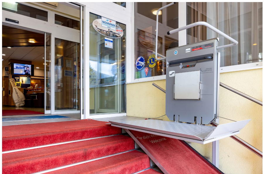
Eingang mit Treppenlift
