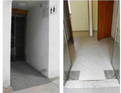
Eingang barrierefreies WC Park
