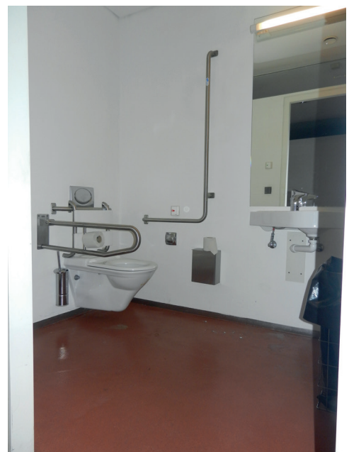
Toilette im UG
